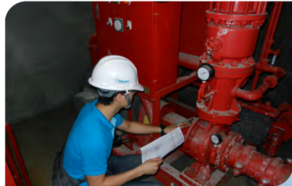
泵浦機房進行各項檢察
