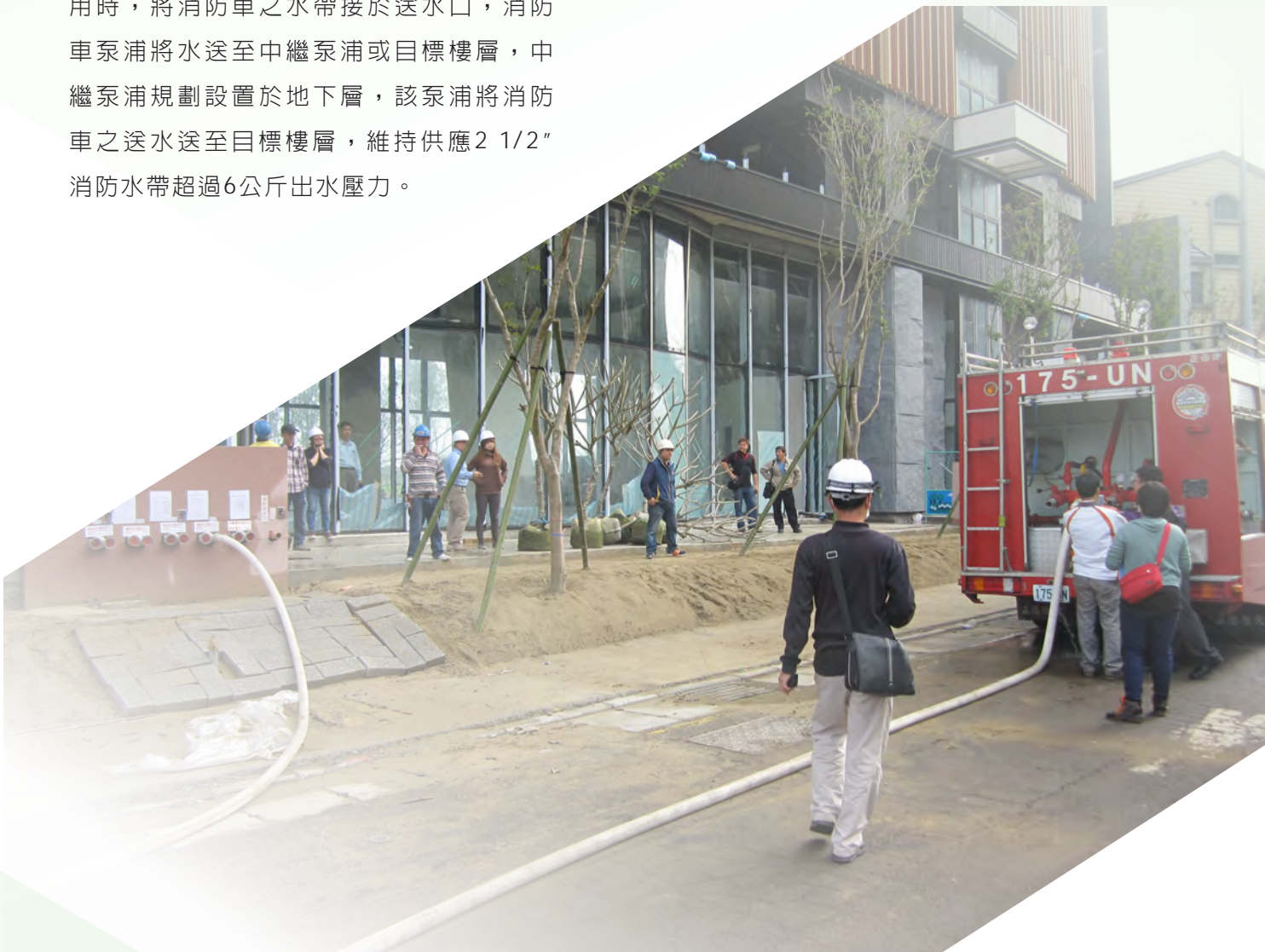
消檢測試時，由消防車送水至中繼泵浦
