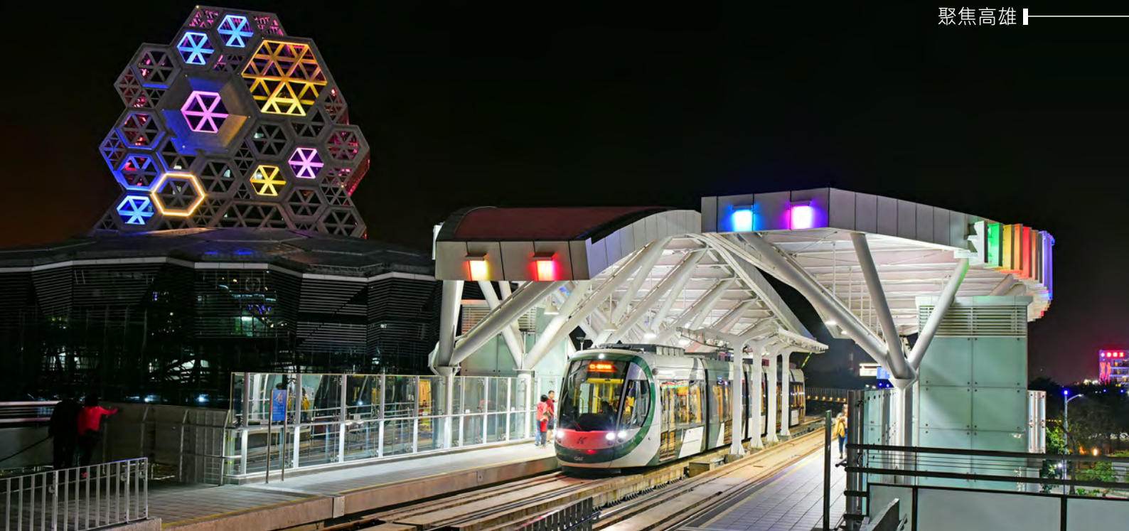
東臨港線C32站(凱旋公園站)~C37站(前鎮輕軌機廠站)，預計109年底可全數完工。
