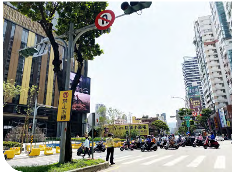
第二階段關注度最高的美術館路與大順路預定路段，該路段施工目前暫停。
