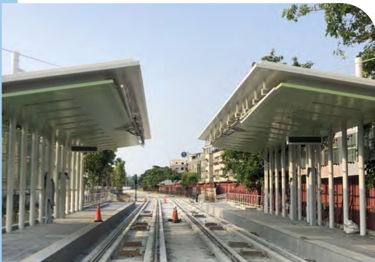
東臨港線C32站(凱旋公園站)~C37站(前鎮輕軌機廠站)，預計109年底可全數完工。
