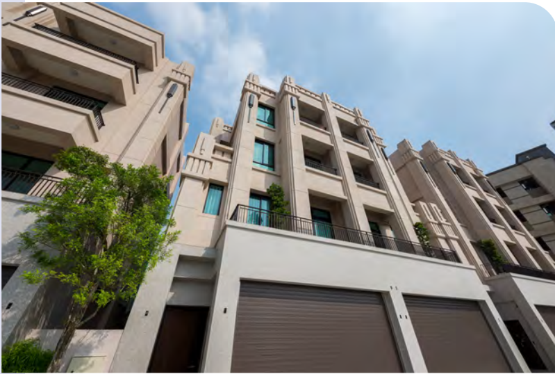
頌真建設蓋房子照起工、落實養護，打造安心建築。
