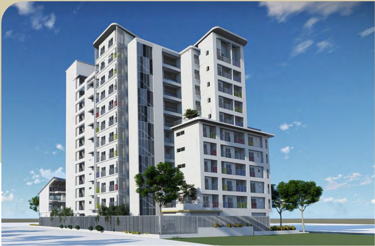
「中都社宅」位於三民區中都重劃區，為地上11層、地下2層大樓，共114戶。
