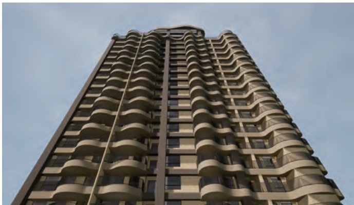
翠三案(在建工程一)
