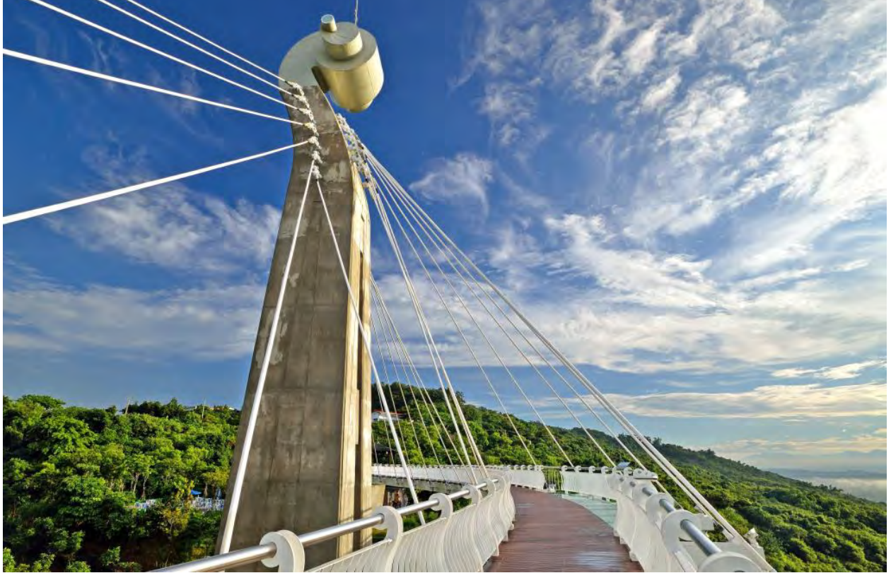
崗山之眼 照片來源:高雄岡山區公所網站
