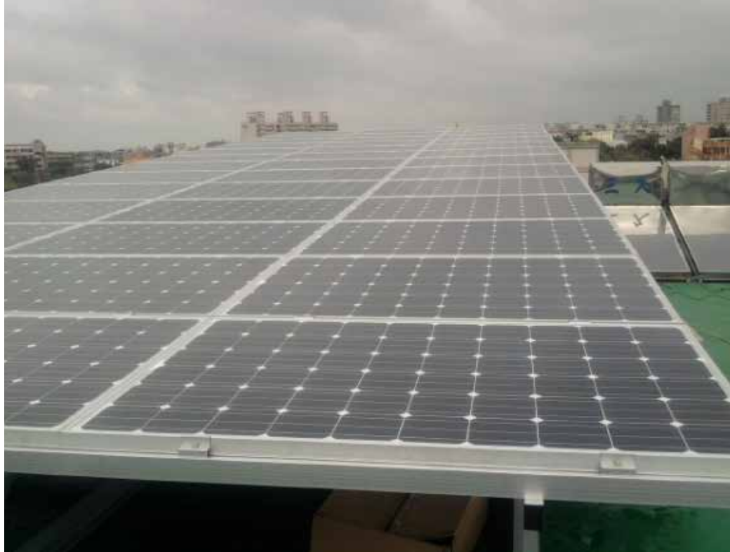
屋頂設置太陽能板
