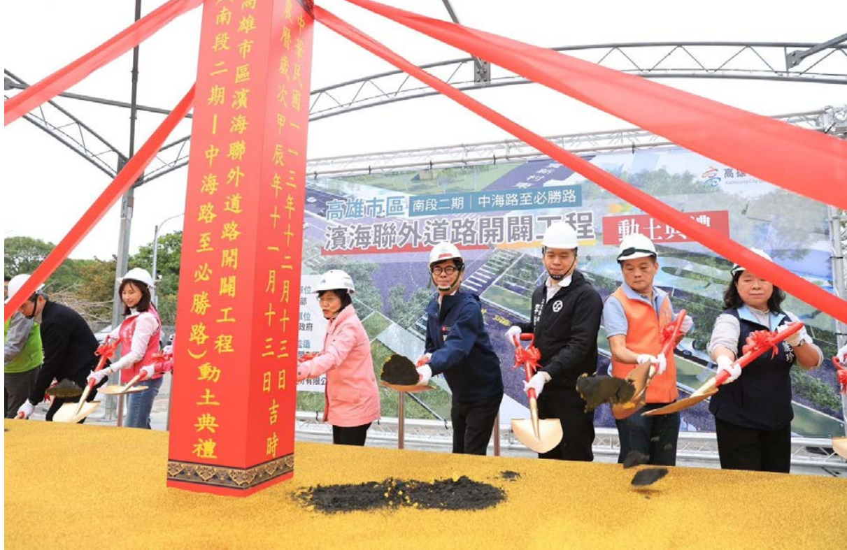
高雄濱海聯外道路南段2期動土
