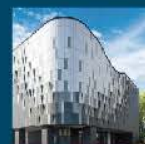
施工完成示意
