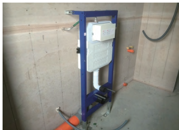
圖4.當層配管-馬桶背牆水箱組件施工照片
