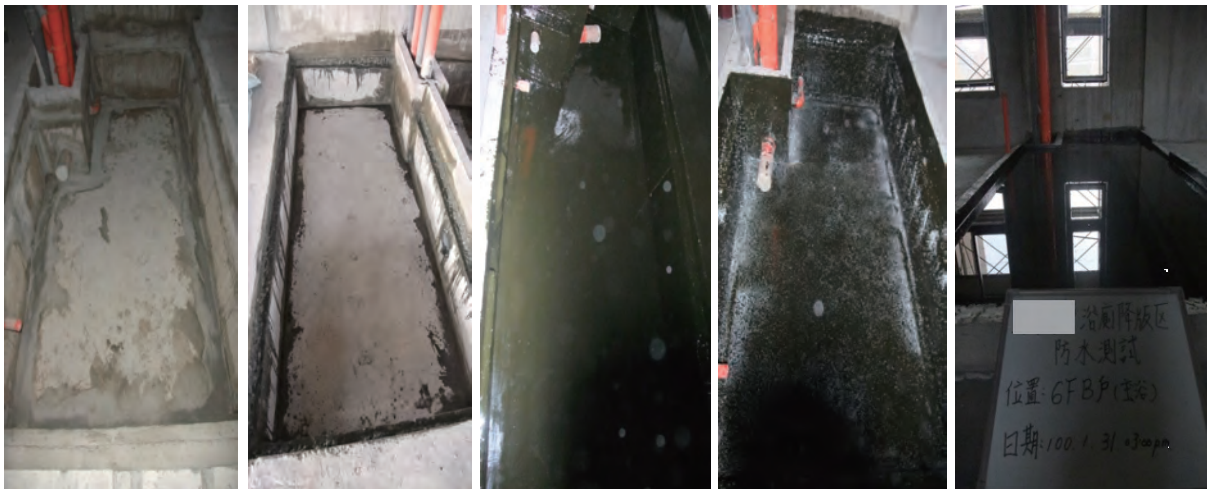
樹脂砂漿 陰角補強
