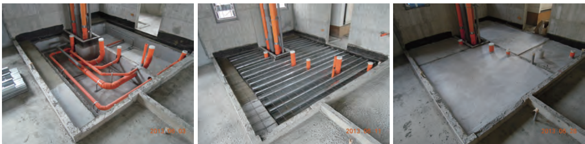
降板區防水壓層、洩水坡度、管線配置作業
