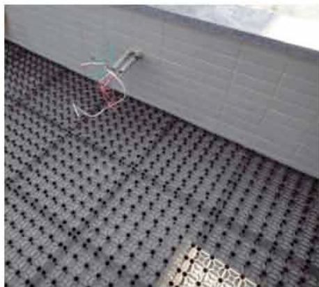
照片三：水電管路在牆面出管線
