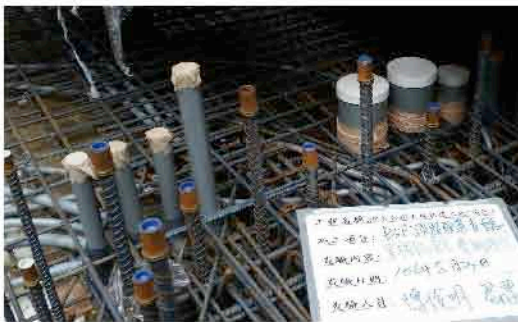
消防火警配管採用PVC管材質配管
