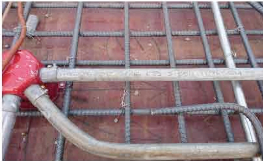
消防火警配管原採用EMT管不燃材質
