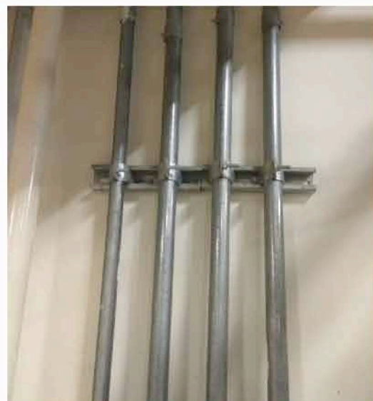
消防明管採不燃管材配設
