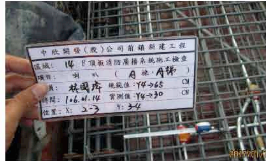
消防火警配管原採用EMT管不燃材質
