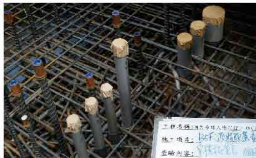
消防火警配管採用PVC管材質配管
