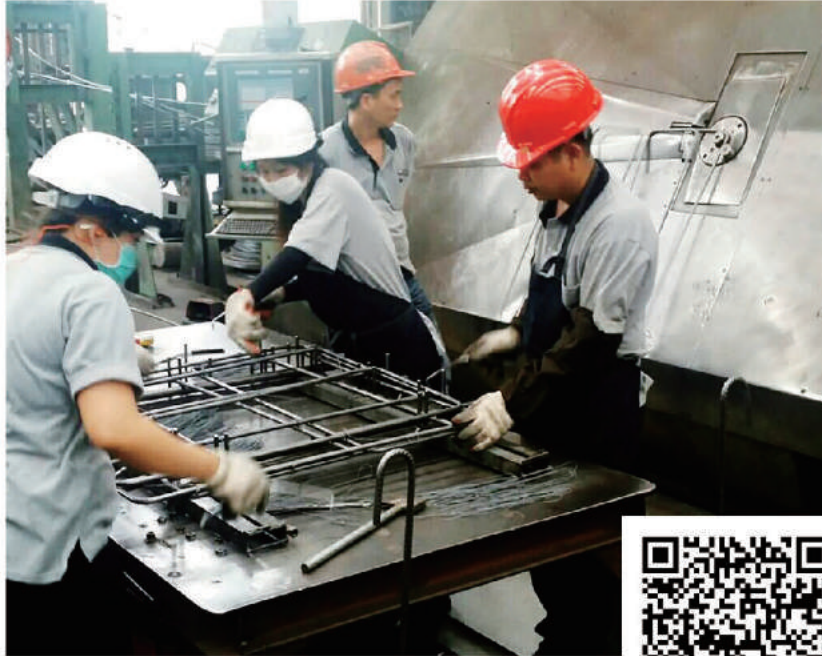
結構安全系統工法-系統化鋼筋加工 影片介紹
