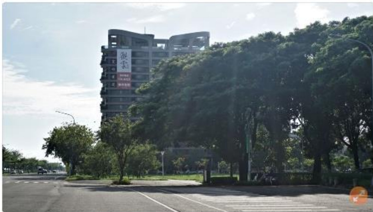
楠梓高雄大學特區皇裕建設成屋案「觀雲3」，今年6月9樓2房2廳2衛浴格局，出現單坪成交35.6萬元，改寫楠梓區新高紀錄。葉家銘攝
