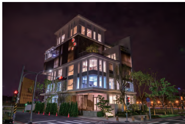
全誠建設公司總部
