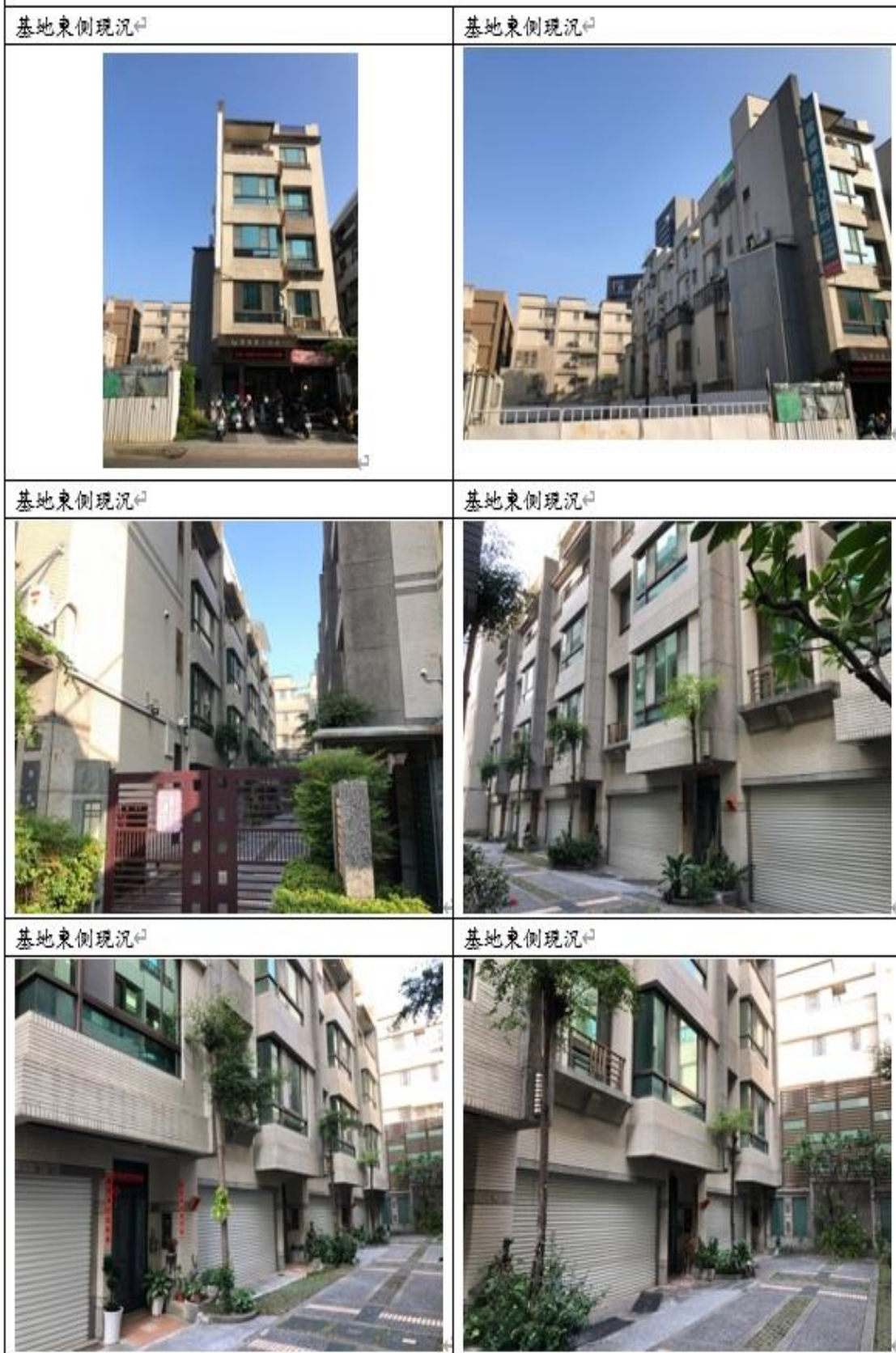
圖 16 東側基地 11/24 現況照片
