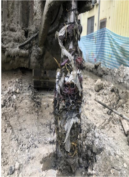
圖 26 地質改良樁施作時發現鐵絲及垃圾
