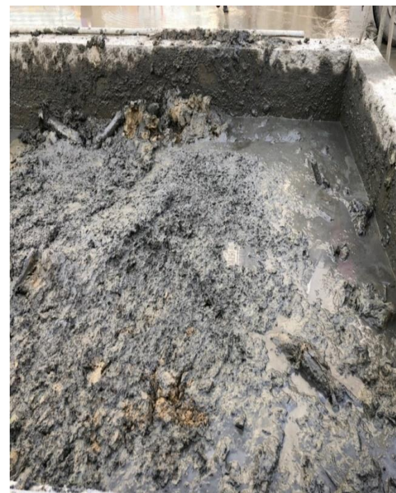
圖 27 連續壁挖掘時挖出垃圾及沙發床彈簧鋼絲 (鐵絲、廢棄貫材、保麗龍及垃圾)
