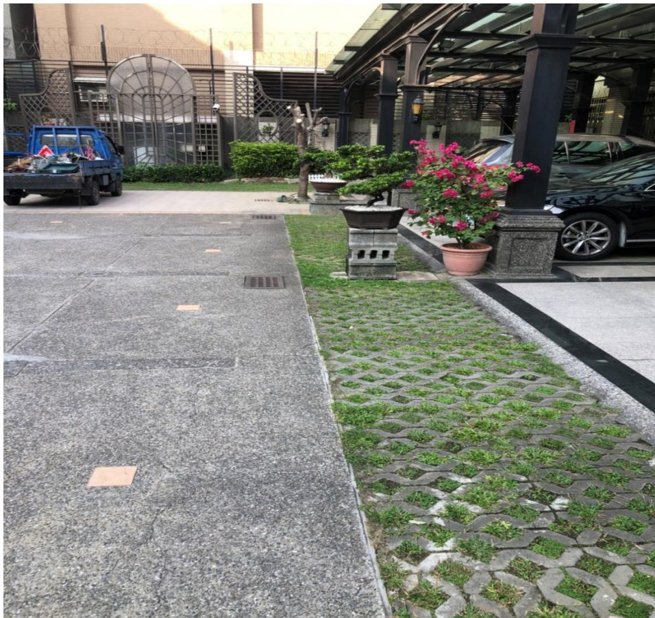
圖 19 西側鄰房前庭(地面無龜裂)
