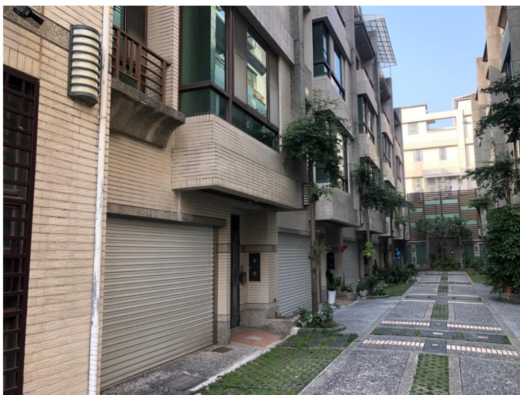
圖 15 東側鄰房前庭(地面龜裂填補)
