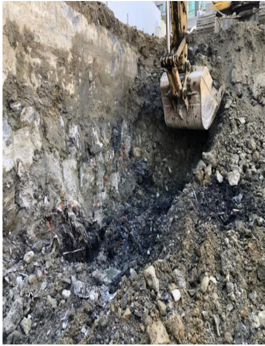
圖 28 開挖時挖出垃圾廢棄物情況(破磚塊、木塊)
