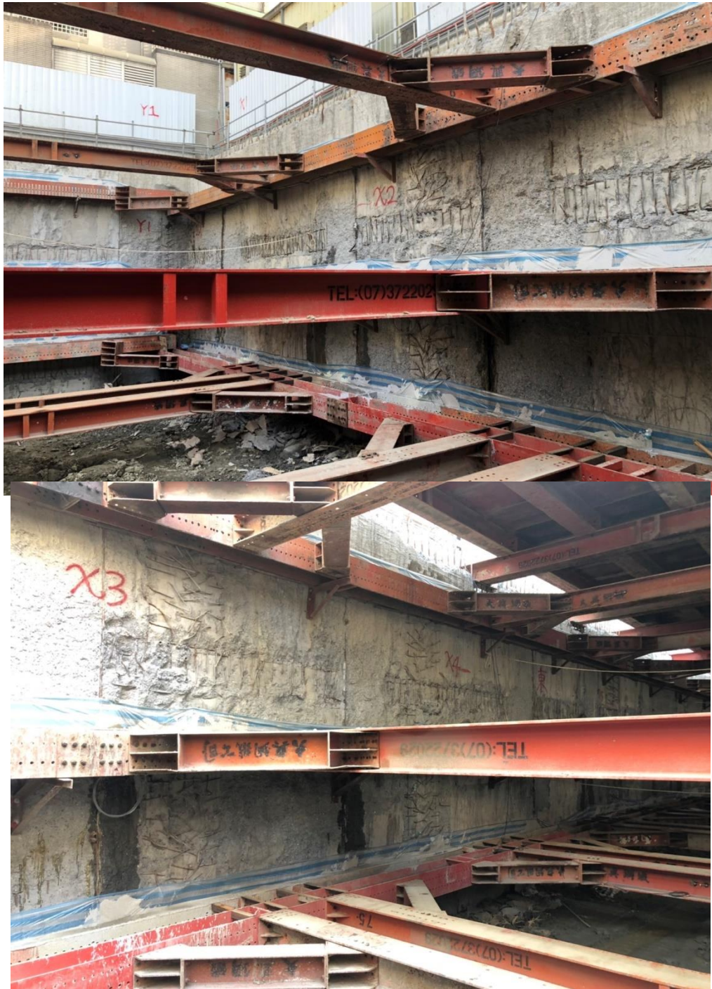
圖 30 連續壁面潔淨(表面為預留鋼筋)
