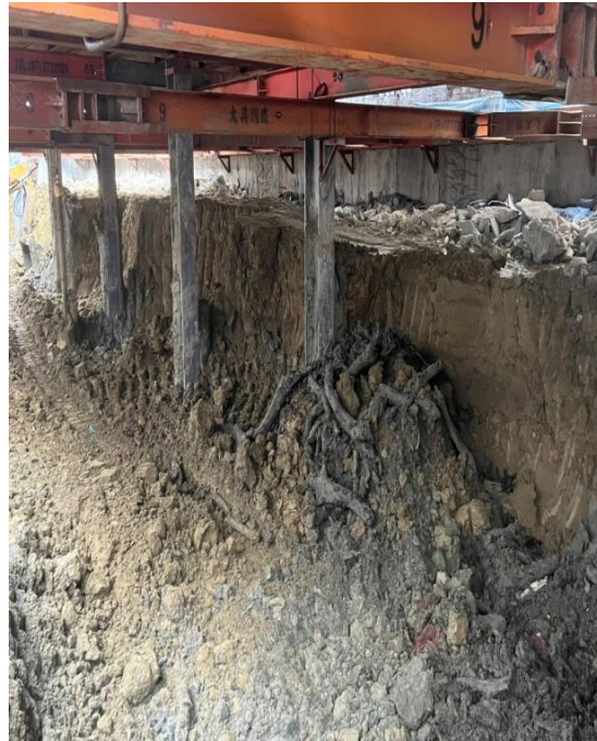
圖 28 開挖時挖出垃圾廢棄物情況(破磚塊、木塊)
