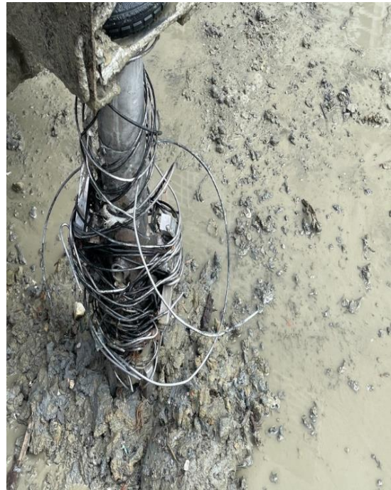
圖 26 地質改良樁施作時發現鐵絲及垃圾
