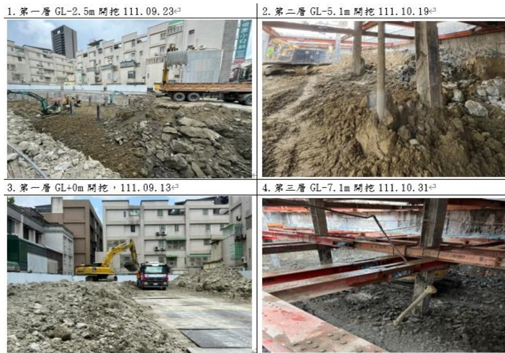
圖 22 第一、二層開挖時發現改良樁水泥漿體
