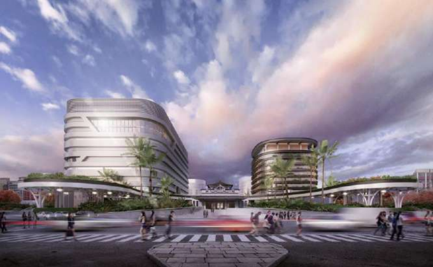
新高雄車站 完工
