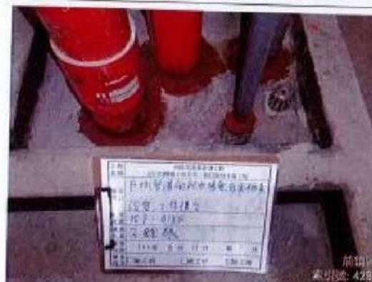
照片說明：15樓A13戶主浴管道間防火填塞。
