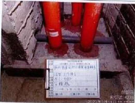
照片說明：15樓A13戶工作陽台管道間防火填塞。
