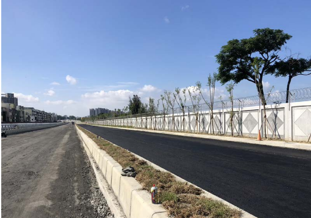
新台17線南段工程進度
